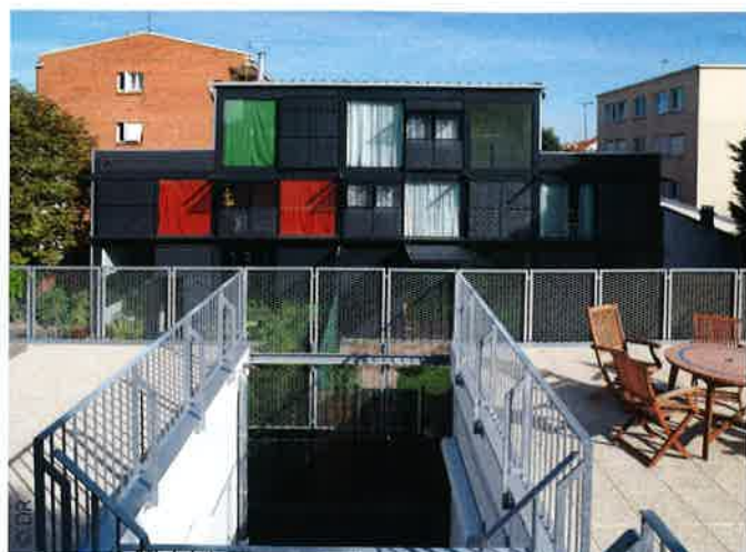
L'entreprise a réalisé des chantiers étonnants comme cette construction moderne habillée de métal déployé.
