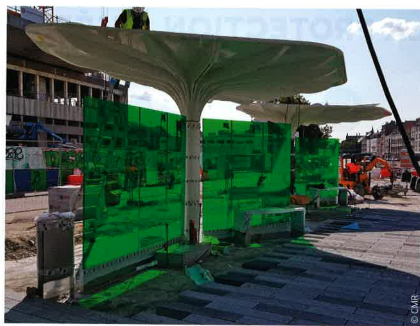
Un abri de tramway réalisé à partir d'un logiciel 3D par la métallerie CMR.
